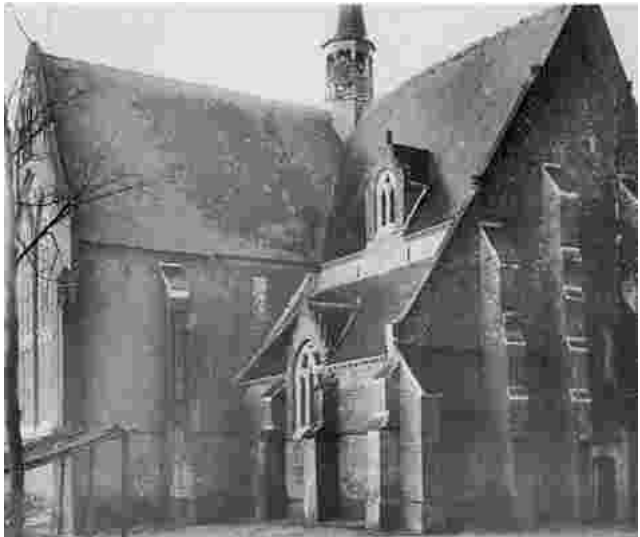
De kerk St.Petrusbanden, foto1888. Na het instorten van de toren was de kerk 2 traveeën korter dan nu. Hij kreeg een kleine ingangdeur in de muur die met de stenen van de toren was gemetseld en gesteund werd.
