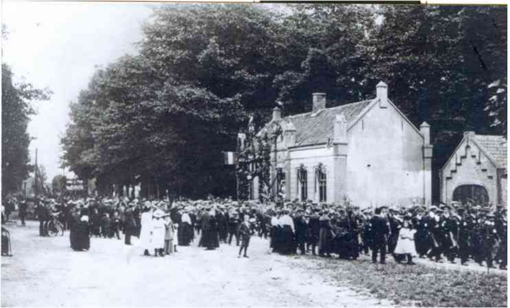
Het 1 e Raadhuis van Bergeijk aan “de Straat” met rechts zichtbaar het brandweershuisje.
