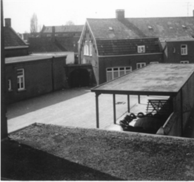
De speelplaats achter de school en Huize d'Alzon
